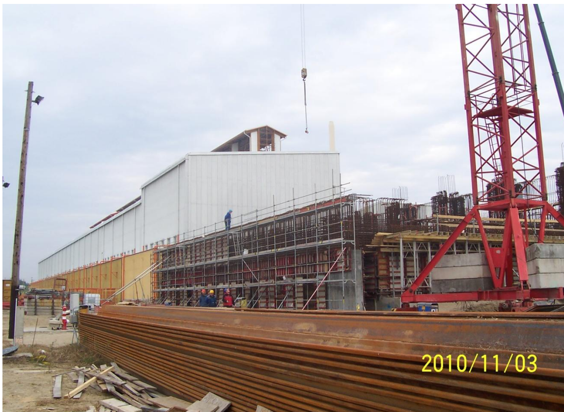
1.2-1. kép: A III. ütem 1. fázis építésének munkái
